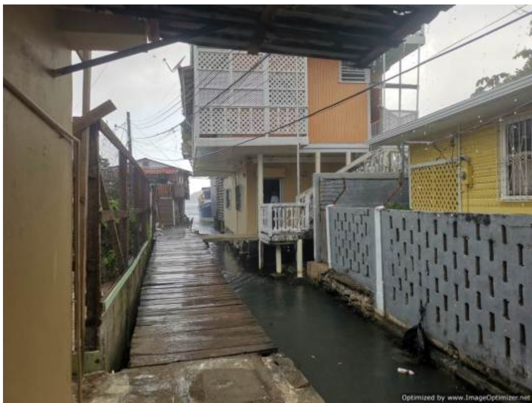
calle de acceso al muelle
