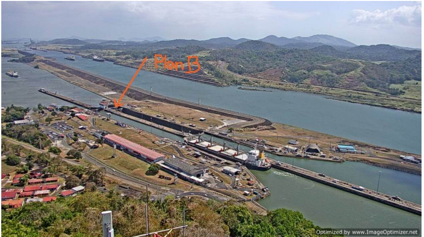
foto hecha por las cámaras del canal
