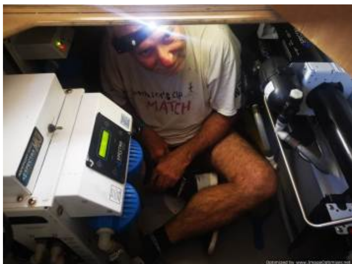
en plena instalación
