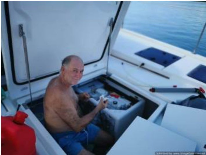
aprovechando a cambiar el aceite del generador
