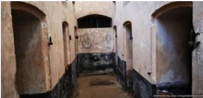
corredor de módulo
