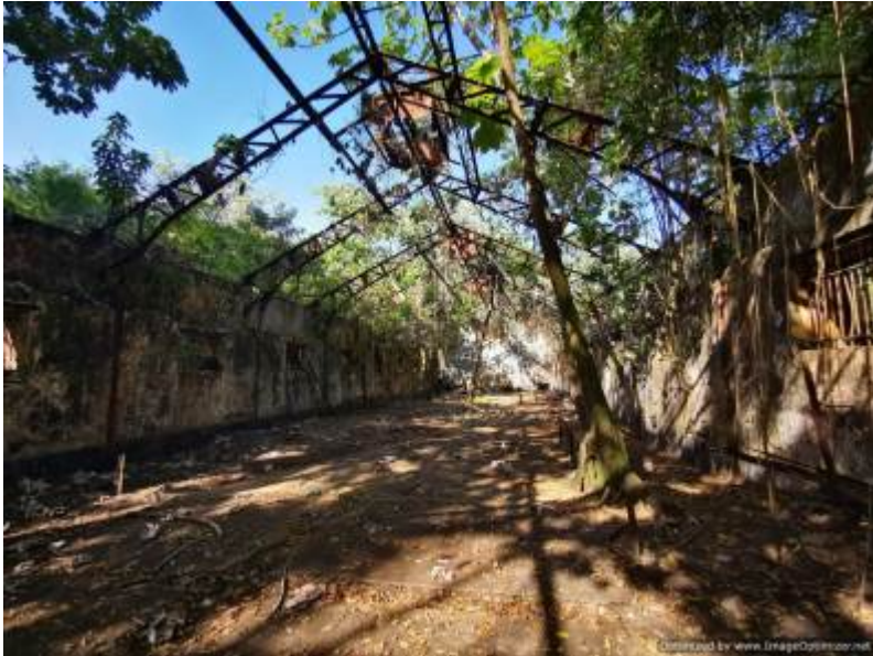
antigua cubierta de un modulo
